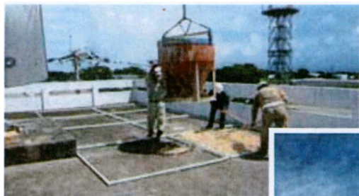
化石サンゴ敷均状況
