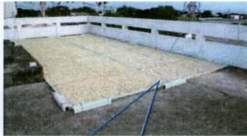
化石サンゴ敷均完了状況
